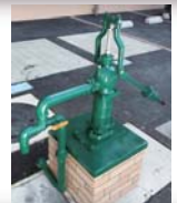
非常用にも使用できる 井戸水を完備
