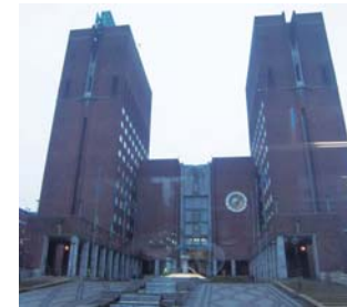
オスロ市庁舎
